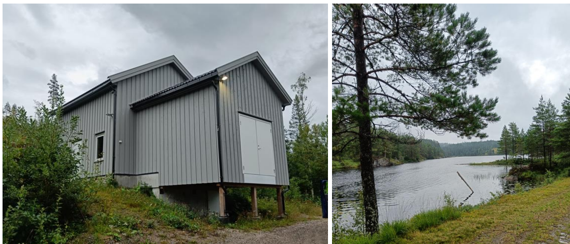
Figur 2-5. Skrømevatn og vannbehandlingsanlegget til Skrøme.
